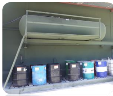
Zona de almacenamiento exterior de Residuos Peligrosos, debidamente cubierta e impermeabilizada
